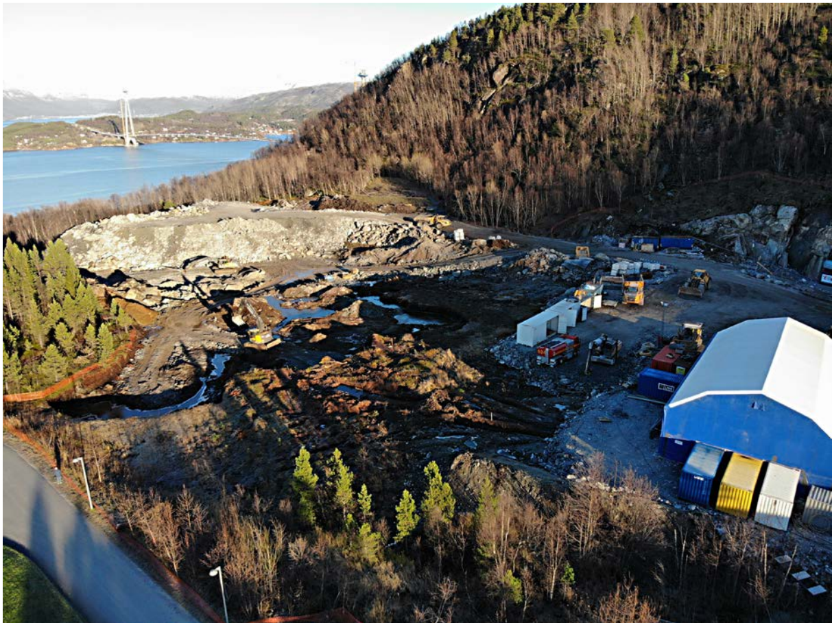
Arbeid med tunell og vei til nytt sykehus i Narvik. Hålogalandsbrua skimtes i bakgrunnen.
